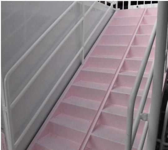
展望デッキに登る階段には自転車を上げるためのレールが設置されていました。
