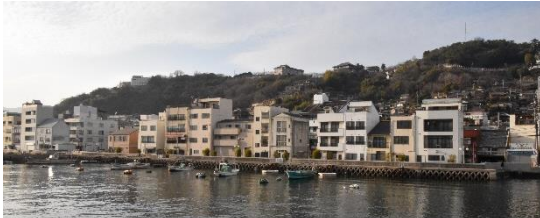
「ニューびんご」に乗船して尾道港に向かいました。尾道水道沿いの建物です。
